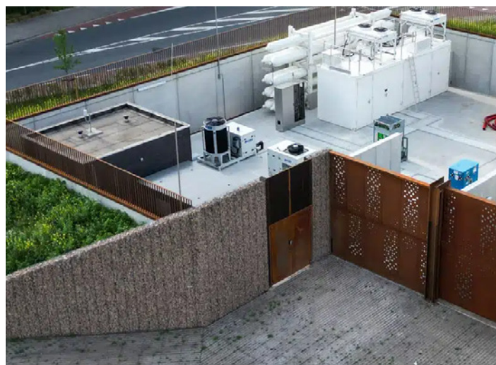
Geclusterde facilitaire voorzieningen aan het oog onttrokken door zorgvuldig ontworpen gevel
