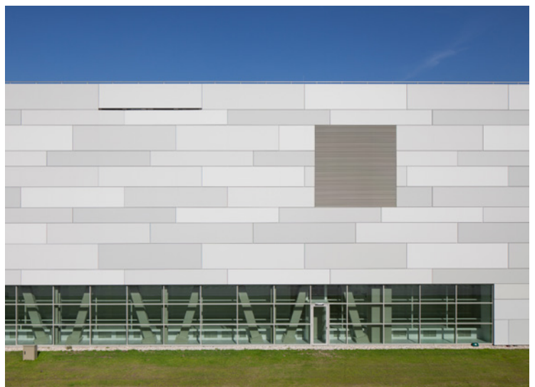
Cleanroom ASML locatie Veldhoven. Een introvert gebouw
